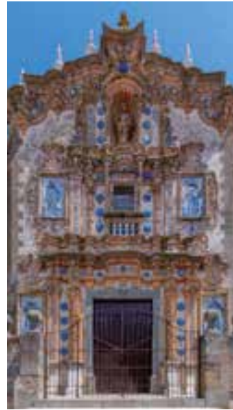
Fachada de la iglesia de San Bartolomé.
