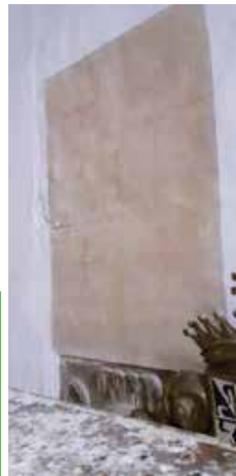
Aspecto de una de las catas.
